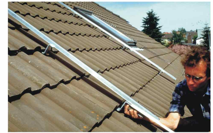
Installation des rails de fixation
