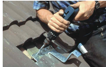
Mise en place des pattes de fixation
